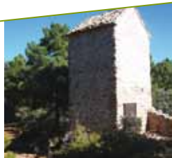
Transformador Eléctrico 5a
