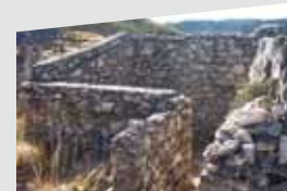
Edificio central de la posición
