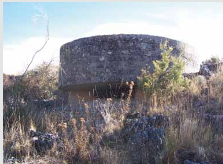
Nido de ametralladora de la fortificación.
