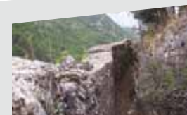
Interior de la trinchera que mira al valle del río Darro.
