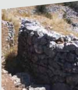
Trinchera construida con piedra sin argamasa
